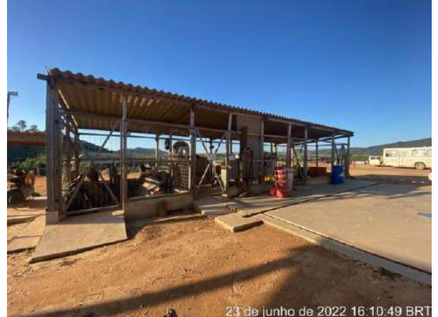
Foto 76 – Baias do canteiro industrial. (Data:23/06/2022)
