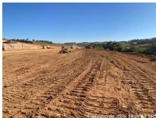
Foto 369 – Movimentação de terra, margem direita. (Data:04/07/2022)
