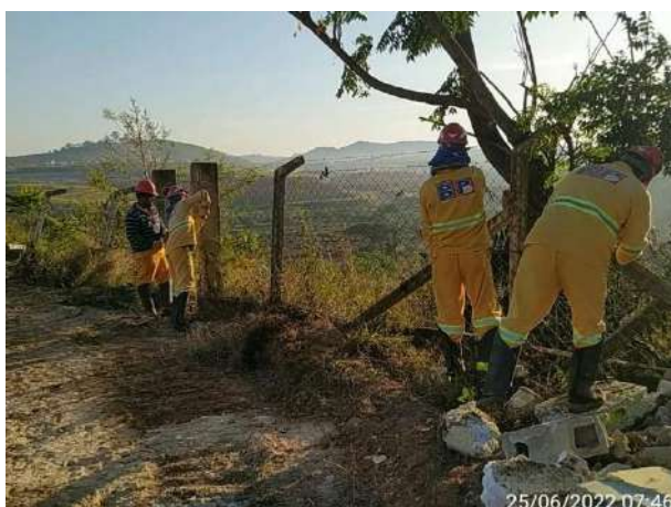
Foto 346 – Demolição das estruturas de alambrado. (Data:25/06/2022)
