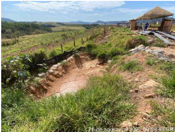
Foto 288 – Leira e gramíneas e disciplinamento de águas pluviais. (Data:26/08/2022)
