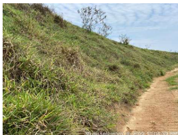
Foto 246 – Vista cobertura vegetal. Bota Fora 01. (Data: 30/09/2022)
