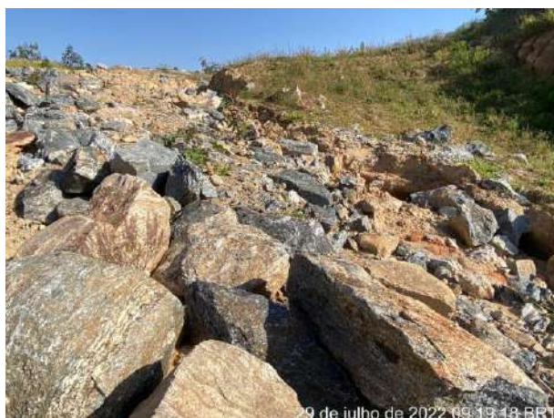
Foto 231 – Enrocamento com disciplinamento do fluxo para as caixas de retenção. (Data: 29/07/2022)
