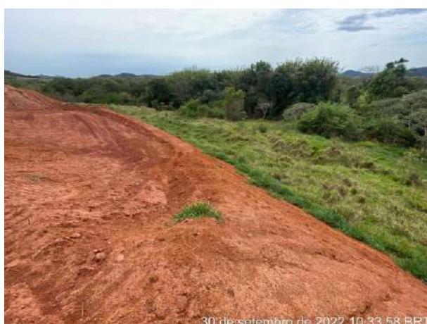
Foto 210 – Leira de proteção no entorno do bota espera com inclinação para a saída do talude. (Data:30/09/2022)
