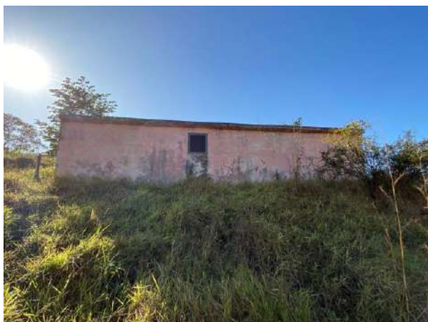
Foto 350 – Demolição da estrutura da estrutura 124, lote 23. (Data:29/07/2022)
