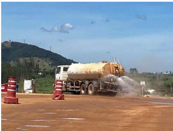
Foto 308 – Umectação de vias interna. (Data:10/06/2022)
