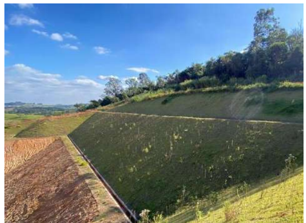
Foto 282 – Grama e canaleta de drenagem. (Data:17/09/2022)
