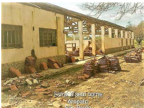
Foto 358 – Demolição da estrutura 040, lote 23. (Data:27/09/2022)
