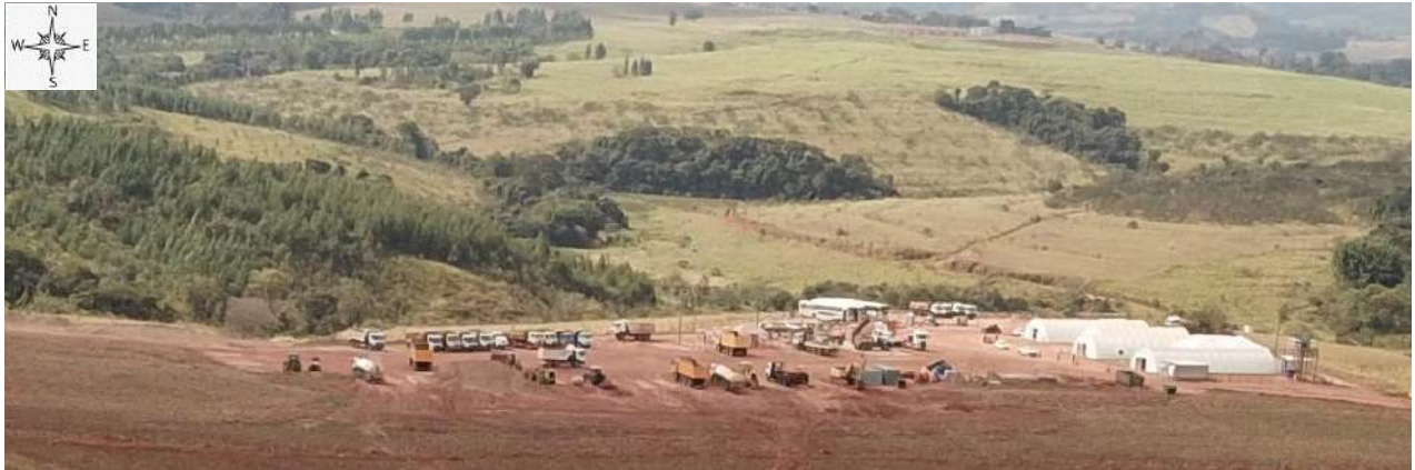
Foto 283 – Canteiro industrial. (Ilustrativo)
