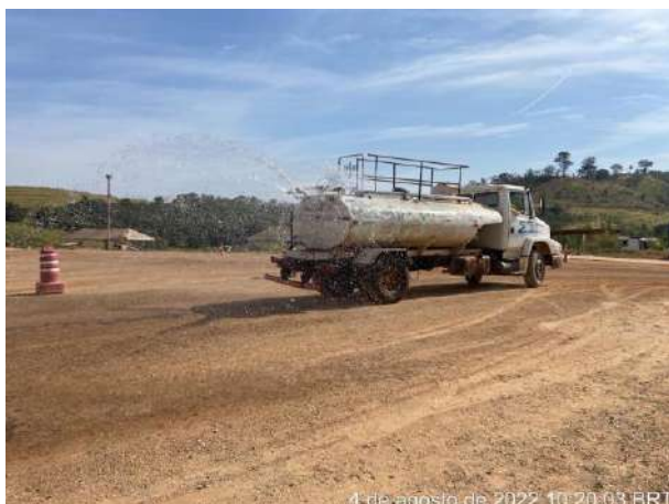
Foto 316 – Umectação de vias interna. (Data:04/08/2022)
