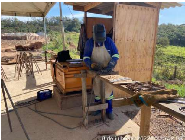
Foto 127 – Construção com solda do tripé. (Data:08/07/2022)
