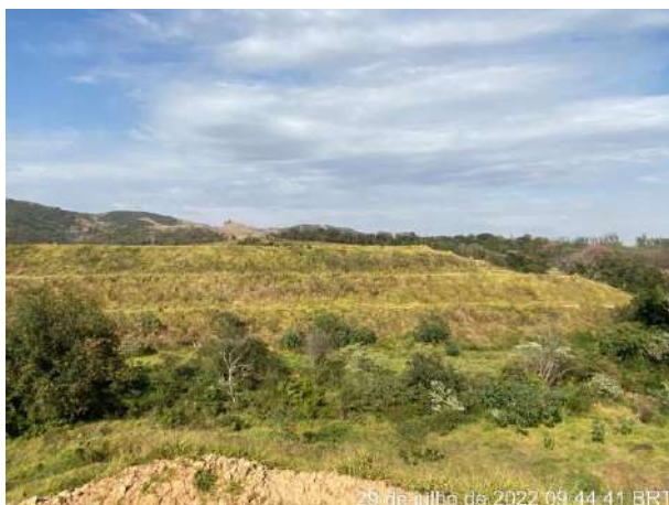
Foto 225 – Vista da cobertura vegetal. Bota Fora 01. (Data: 29/07/2022)
