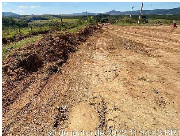
Foto 284 – Leira e gramíneas e disciplinamento de águas pluviais. (Data:30/06/2022)
