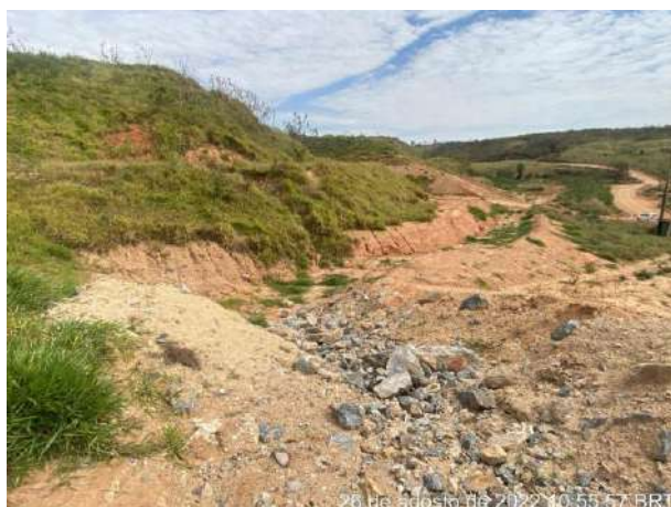
Foto 239 – Enrocamento com disciplinamento do fluxo para as caixas de retenção. (Data: 26/08/2022)
