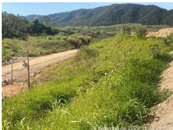
Foto 252 – Talude leira e gramíneas. (Data:27/06/2022).
