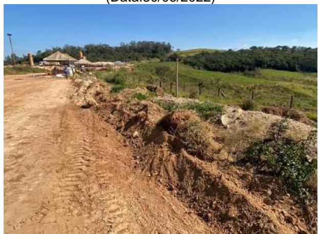
Foto 287 – Talude, leira e gramíneas. (Data:30/07/2022)
