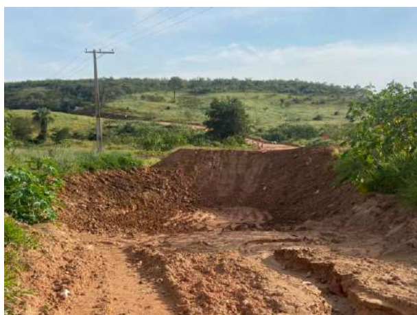
Foto 223 – Cacimba de contenção. (Data: 27/06/2022)
