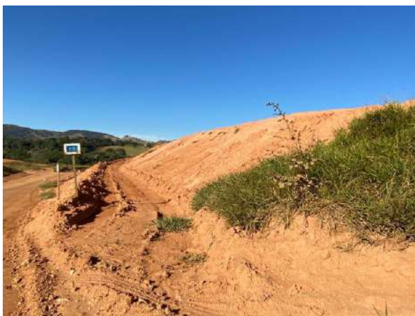
Foto 192 – Leira de proteção no entorno do bota espera com inclinação para a saída do talude. (Data: 14/06/2022)
