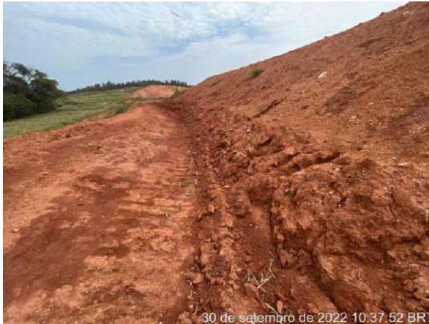
Foto 212 – Vista para leira e inclinação e direcionamento para saída do talude. (Data:30/09/2022)
