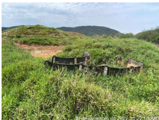
Foto 272 – Barreira silt face para reteno de sedimento. (Data: 30/09/2022)
