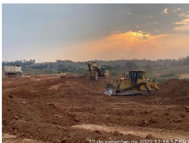
Foto 382 – Movimentação de terra, margem esquerda. (Data:12/09/2022)
