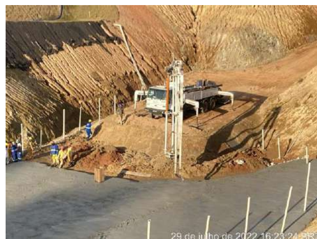
Foto 373 – Concretagem da Ogiva. ( Data: 29/07/2022)
