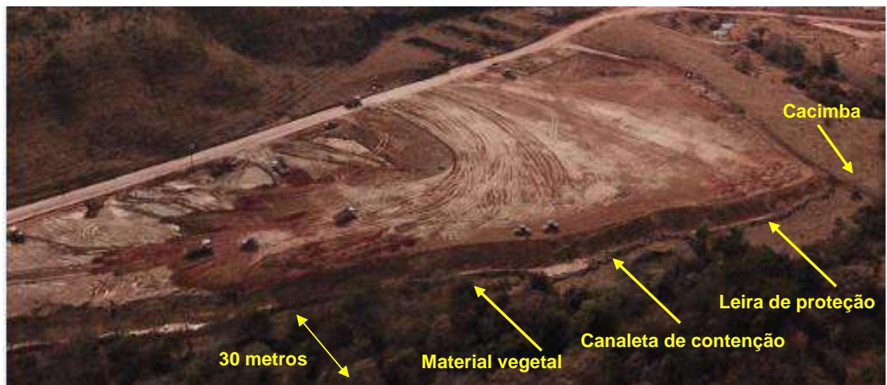
Foto 249 – Bota Fora 2, vista para proteções preventivas em seu entorno.
