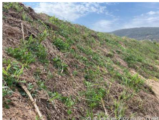
Foto 259 – Germinação do material vegetal aplicado no talude. (Data: 29/07/2022)
