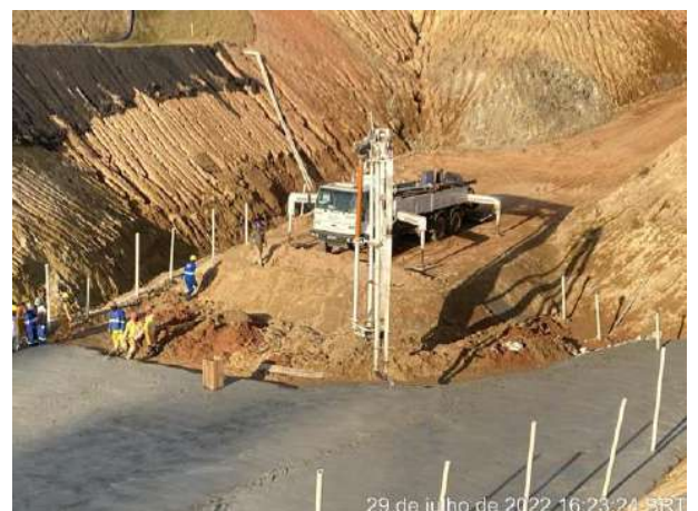
Foto 379 – Aplicação de Concreto. (Data: 29/08/2022)
