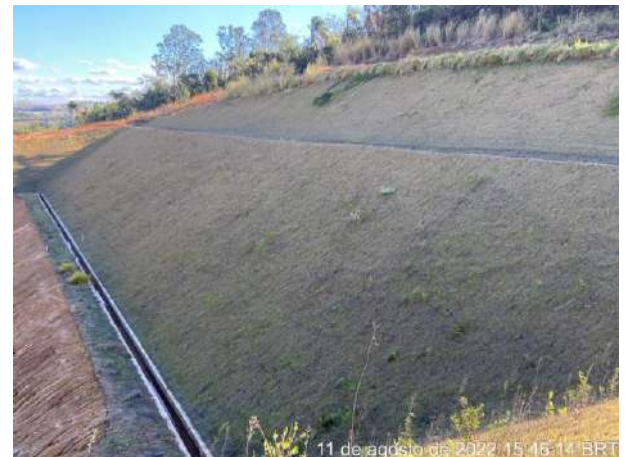
Foto 280 – Grama e canaleta de drenagem. (Data:11/08/2022)
