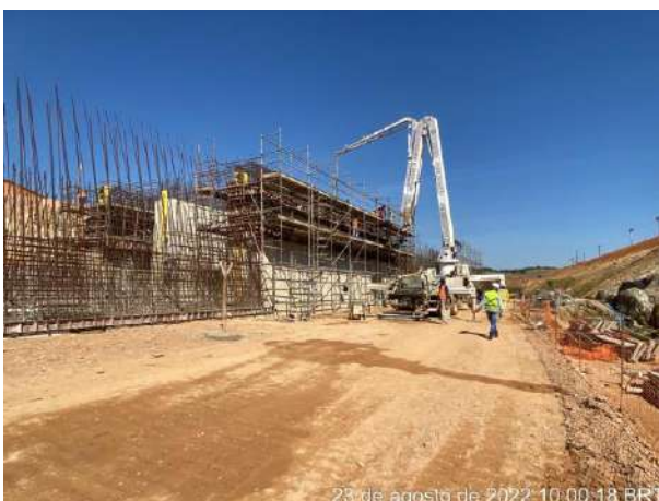
Foto 378 – Aplicação de Concreto. (Data:23/08/2022)
