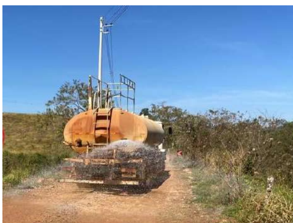
Foto 320 – Umectação de vias interna. (Data:04/09/2022)
