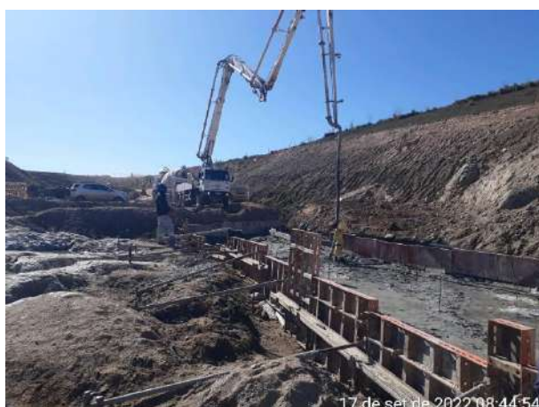
Foto 384 – Aplicação de Concreto. (Data:17/09/2022)
