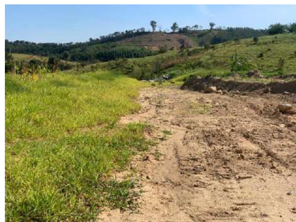
Foto 255 – Disciplinamento de águas pluviais. (Data: 27/06/2022)
