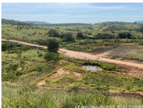
Foto 221 – Cacimba de contenção. (Data: 27/06/2022)
