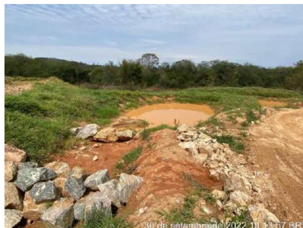
Foto 271 – Cacimba de reteno de sedimento com material rochoso. (Data: 30/09/2022)
