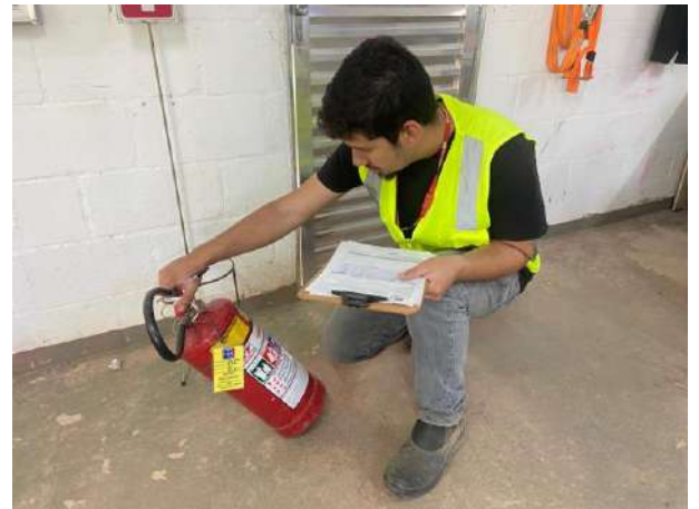
Foto 136 – Check list de extintor. (Data: 18/08/2022)
