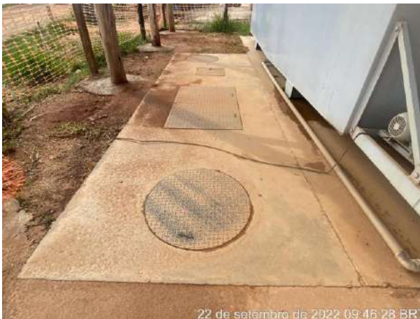
Foto 298 – Vistora da caixa SAO. (Data: 22/09/2022)
