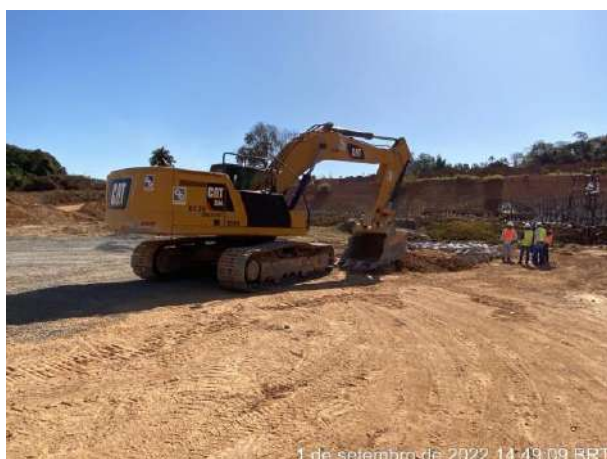
Foto 380 – Movimentação de terra, margem direita. (Data:01/09/2022)
