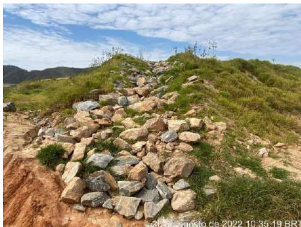
Foto 266 – Enrocamento com disciplinamento do fluxo para as caixas de retenção. (Data: 26/08/2022)
