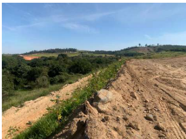
Foto 254 – Talude leira e gramíneas. (Data: 27/06/2022)
