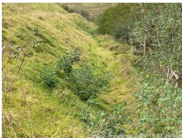
Foto 262 – Talude leira e gramíneas. (Data: 26/08/2022)
