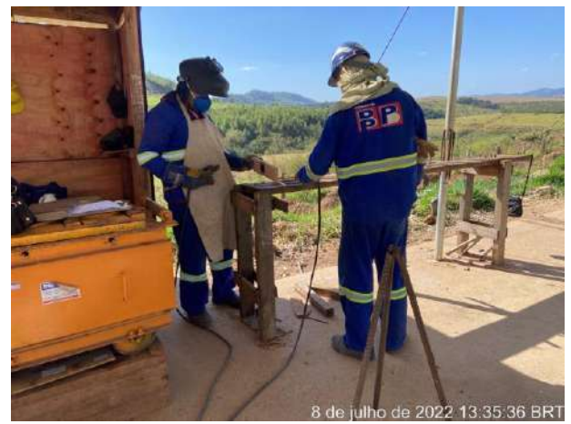
Foto 126 – Construção com solda do tripé. (Data: 08/07/2022)
