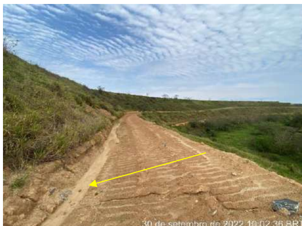
Foto 243 – Leira de proteção no entorno. Bota Fora 01. (Data: 30/09/2022)
