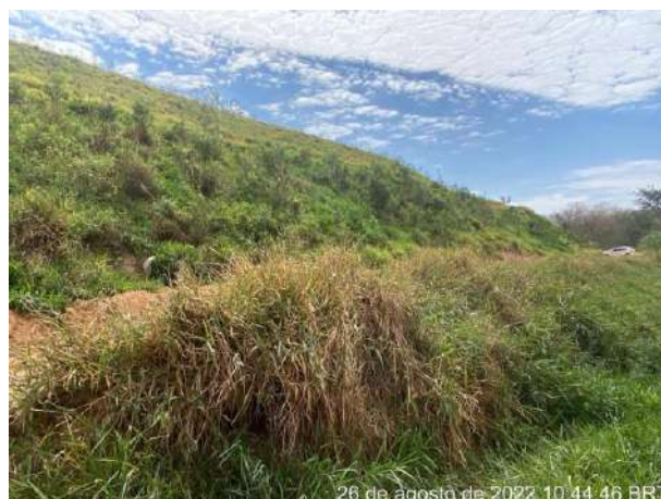
Foto 240 – Disciplinamento do fluxo para as caixas de retenção Bota Fora 01. (Data: 26/08/2022)
