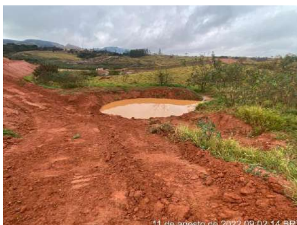
Foto 209 – Vista para cacimba de retenção de sedimento. (Data:11/08/2022)
