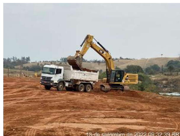
Foto 383 – Movimentação de terra, margem esquerda (Data:13/09/2022)
