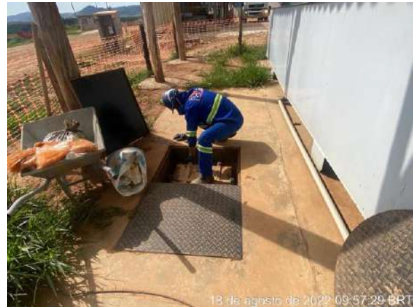
Foto 297 – Limpeza da caixa SAO do tanque de combustível. (Data: 18/08/2022)
