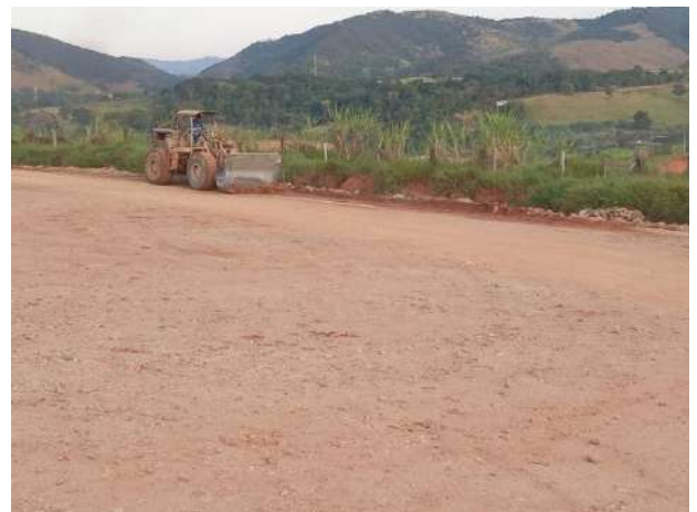
Foto 367 – Movimentação de terra usina de concreto. (Data: 06/06/2022)
