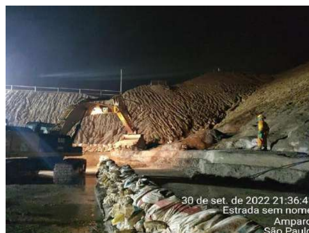
Foto 385 – Aplicação de Concreto. (Data: 30/09/2022)
