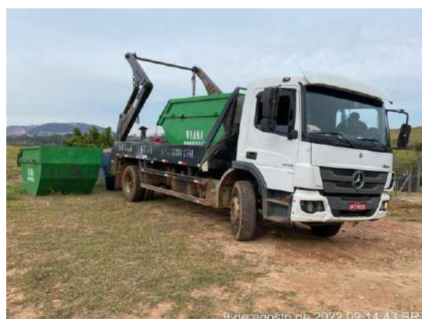
Foto 339 – Troca de caçambas de resíduos comum no canteiro Industrial. (Data:09/08/2022)
