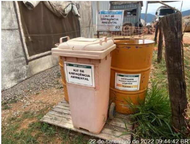
Foto 87 – Kit de atendimento a emergência, Ponto 02 - posto de abastecimento. (Data: 22/09/2022)
