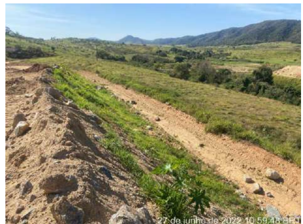
Foto 251 – Germinação do material vegetal aplicado no talude. (Data: 27/06/2022)
