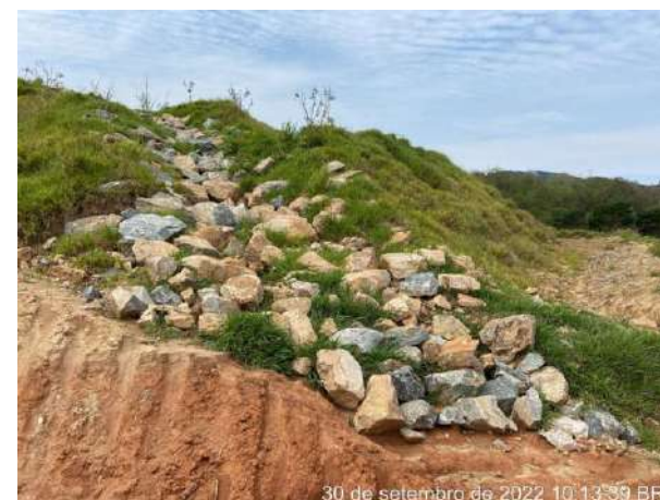
Foto 273 – Enrocamento com disciplinamento do fluxo para as caixas de reteno. (Data: 30/09/2022)
