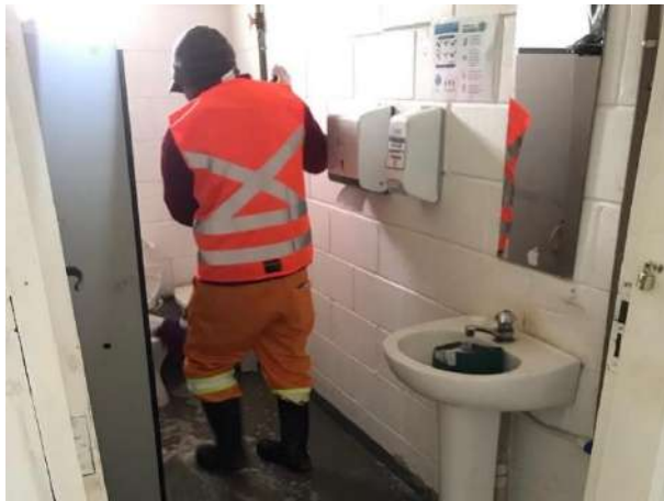
Foto 103 – Limpeza de banheiro administrativo. (Data:19/09/2022)
