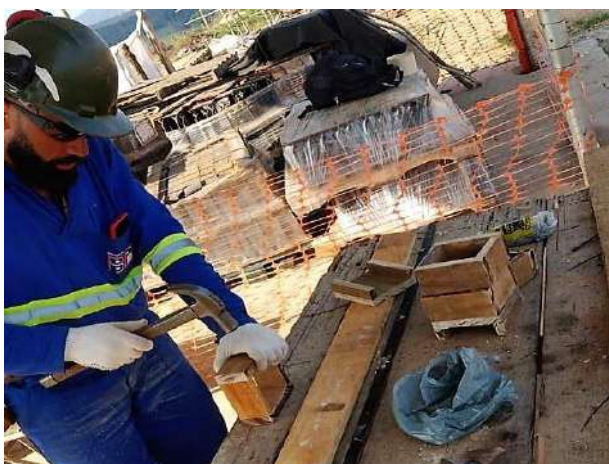
Foto 119 – Construção das caixas no modelo estilo INPA. (Data:04/06/2022)
