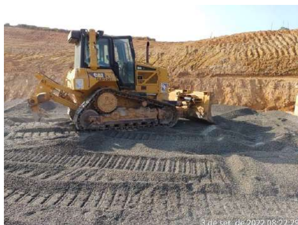
Foto 381 – Movimentação de terra. (Data:03/09/2022)
