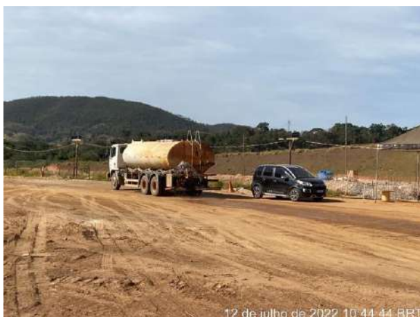
Foto 312 – Umectação de vias interna. (Data:12/07/2022)
