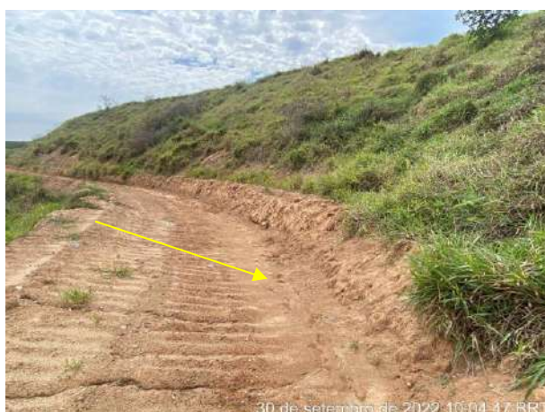
Foto 245 – Vista para Canaleta. (Data: 30/09/2022)
