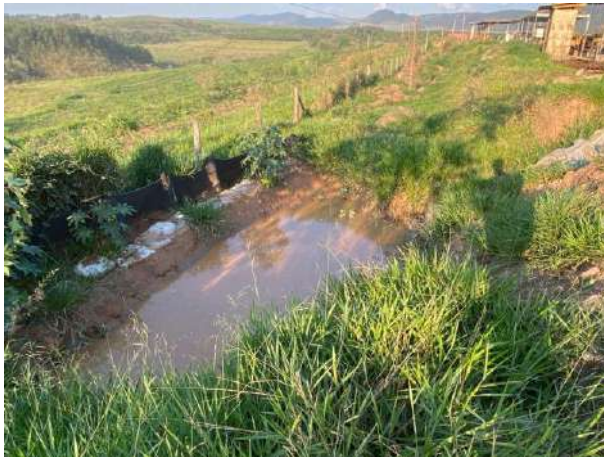
Foto 290 – Leira e gramíneas e disciplinamento de águas pluviais. (Data:26/09/2022)
