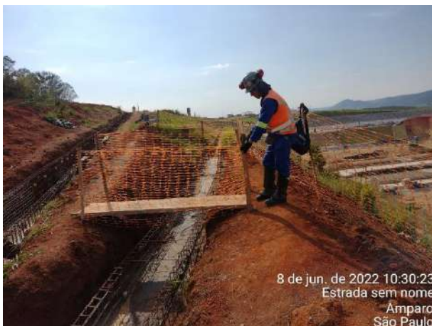
Foto 183 – Proteção com tela tapume no acesso interno da Obra. (Data: 08/06/2022)
