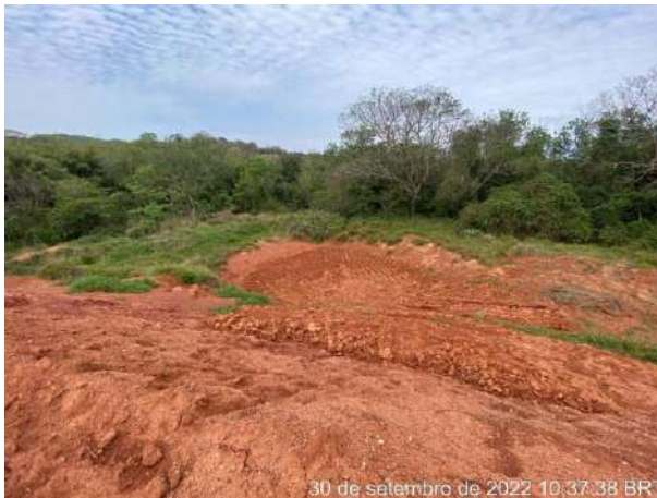
Foto 214 – Vista para cacimba de retenção de sedimento. (Data:30/09/2022)
