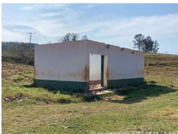
Foto 354 – Demolição da estrutura 041, lote 23. (Data:29/08/2022)
