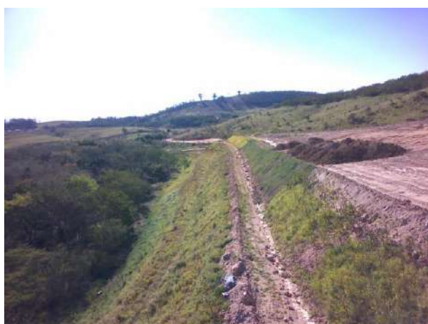
Foto 268 – Talude leira e gramíneas. (Data: 02/09/2022)
