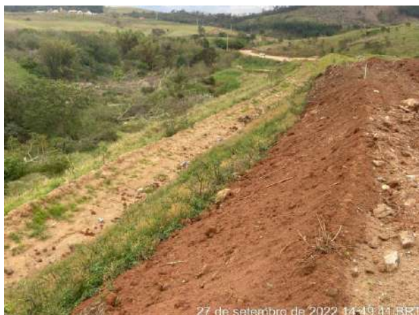
Foto 270 – Reefeioamento de talude com aplicao de solo vegetal e e leira na crista do talude (Data:27/09/2022).
