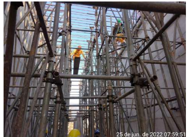
Foto 365 – Aplicação de Concreto. (Data:25/06/2022)
