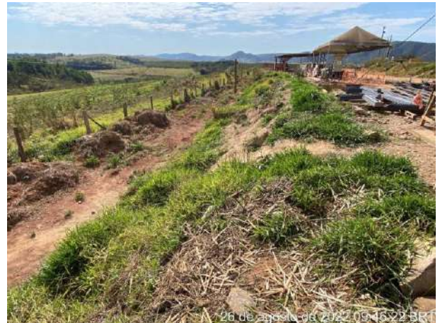
Foto 289 – Talude, leira e gramíneas. (Data:26/08/2022)
