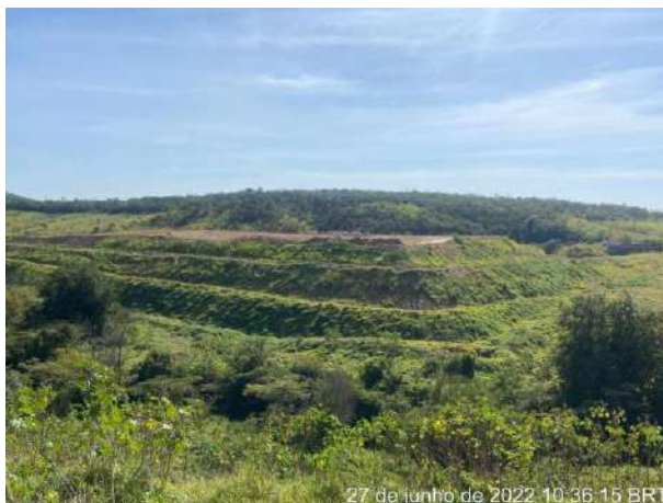
Foto 250 – Talude leira e gramíneas. (Data: 27/06/2022)
