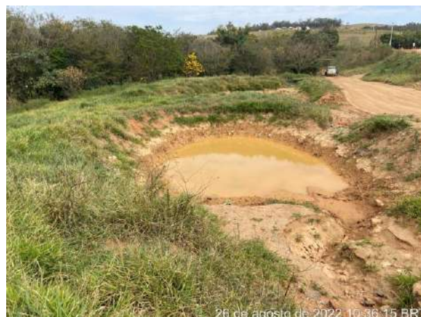
Foto 265 – Cacimba de retenção de sedimento. (Data: 26/08/2022)
