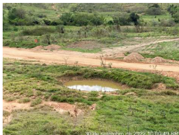
Foto 248 – Disciplinamento do fluxo para as caixas de retenção Bota Fora 01. (Data: 30/09/2022)
