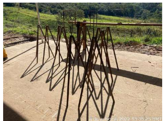
Foto 128 – Solda das partes do Tripé finalizado . (Data: 08/07/2022)
