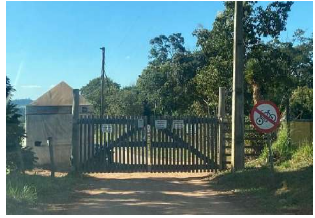
Foto 176 – sinalização na via municipal de acesso a obra. (Data:17/06/2022)
