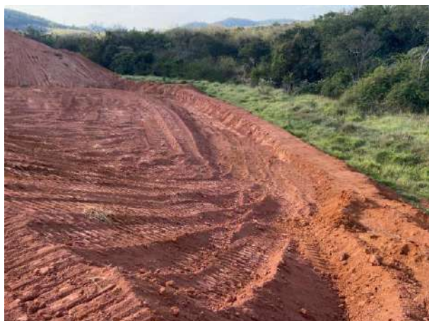
Foto 200 – Vista para leira e inclinação e direcionamento para saída do talude. (Data:15/07/2022)
