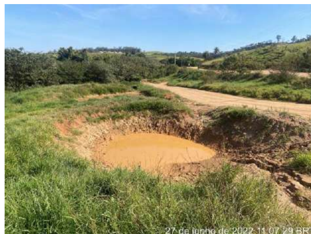
Foto 253 – Cacimba de retenção de sedimento. (Data: 27/06/2022)
