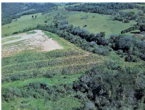
Foto 241 – Vista da cobertura vegetal nos taludes do Bota Fora 01. (Data: 02/09/2022)
