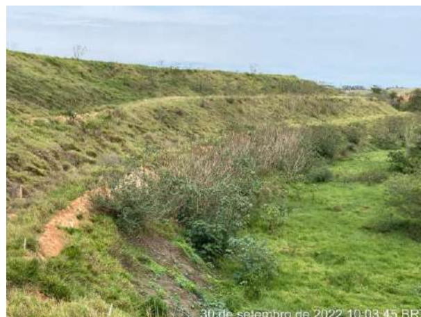
Foto 244 – Vista cobertura vegetal. Bota Fora 01. (Data: 30/09/2022)
