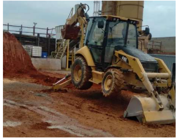
Foto 363 – Movimentação de terra, margem direita. (Data:10/06/2022)
