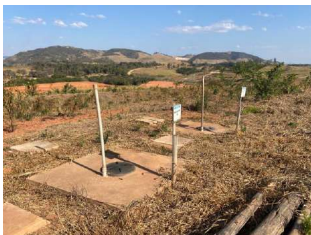
Foto 302 – Biodigestores do canteiro industrial. (Data: 19/07/2022)
