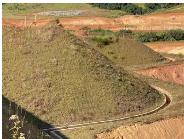
Foto 275 – Grama e canaleta de drenagem. (Data:18/06/2022)
