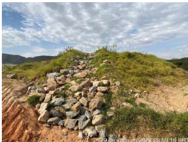
Foto 260 – Disciplinamento de águas pluviais. (Data: 29/07/2022)
