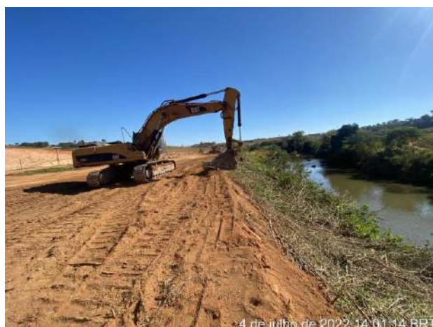
Foto 368 – Movimentação de terra, margem direita. (Data:04/07/2022)
