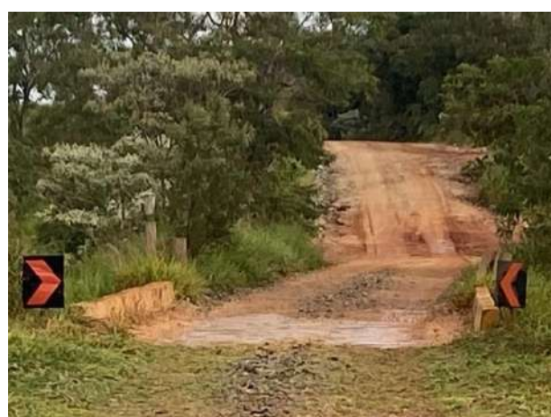
Foto 190 – Sinalização de acesso interno da Obra. (Data: 22/09/2022)
