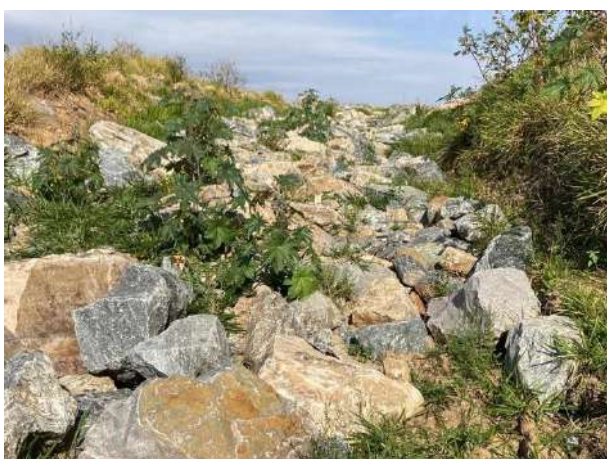
Foto 247 – Enrocamento com disciplinamento do fluxo para as caixas de retenção. (Data: 30/09/2022)
