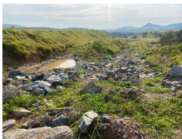
Foto 218 – Cobertura vegetal e enrocamento e disciplinamento do fluxo para a caixa de retenção. Bota Fora 01 (Data: 02/06/2022)
