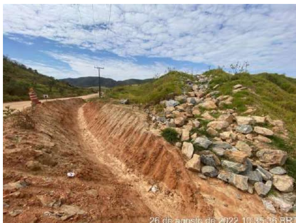
Foto 264 – Disciplinamento de águas pluviais e enrocamento dissipadores. (Data:26/08/2022).
