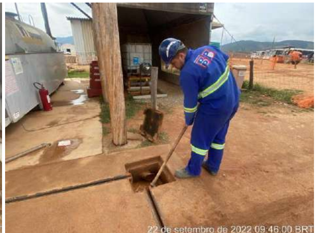
Foto 299 – Manutenção e Limpeza das canaletas e caixa de inspeção na área de abastecimento de combustível. (Data: 22/09/2022)
