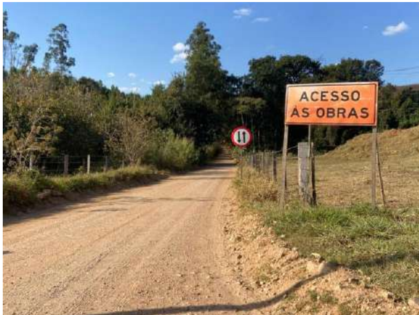
Foto 177 – Sinalização próximo a entrada da obra na via municipal. (Data:29/07/2022)
