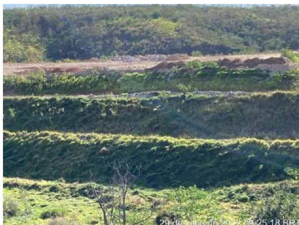
Foto 256 – Talude leira e gramíneas. (Data: 29/07/2022)
