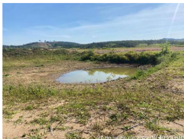
Foto 224 – Cacimba de contenção. Bota Fora 01. (Data: 27/06/2022)
