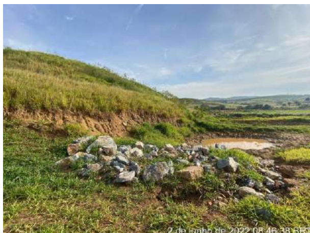
Foto 219 – Enrocamento com disciplinamento do fluxo para as caixas de retenção. (Data: 02/06/2022)
