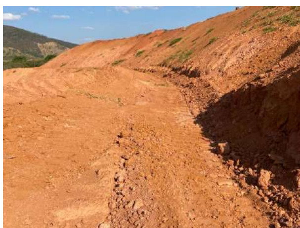
Foto 198 – Leira de proteção no entorno do bota espera com inclinação para a saia do talude. (Data: 14/07/2022)
