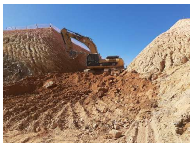
Foto 372 – Movimentação de terra. (Data:26/07/2022)
