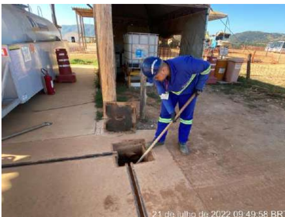
Foto 294 – Limpeza da caixa de inspeção e canaletas da área de manutenção. (Data: 21/07/2022)
