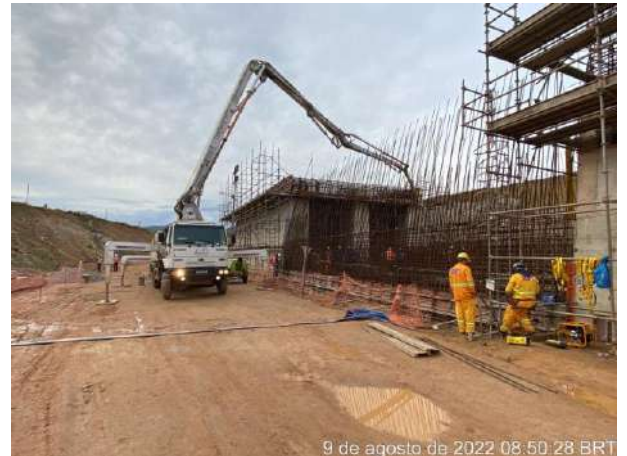
Foto 375 – Aplicação de Concreto. (Data:09/08/2022)
