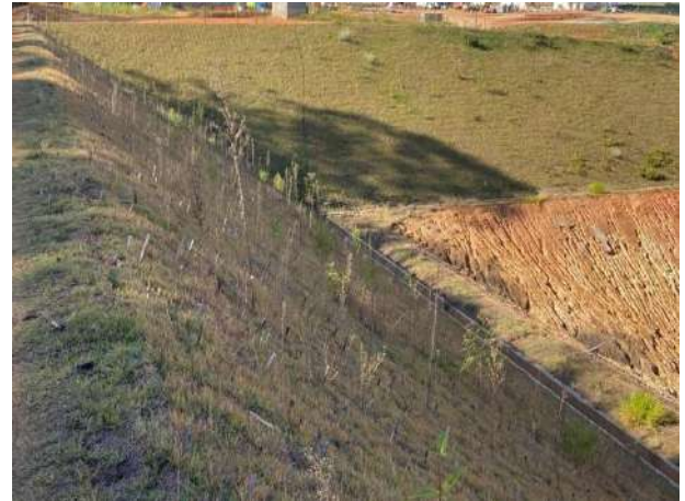
Foto 278 – Grama e canaleta de drenagem. (Data:21/07/2022)
