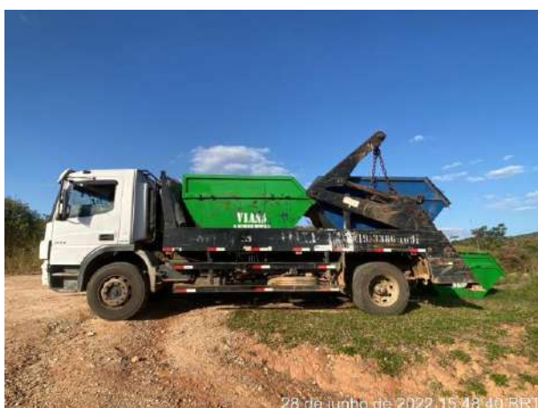
Foto 332 – Troca de caçambas de resíduos de comum no canteiro ADM. (Data:28/06/2022)
