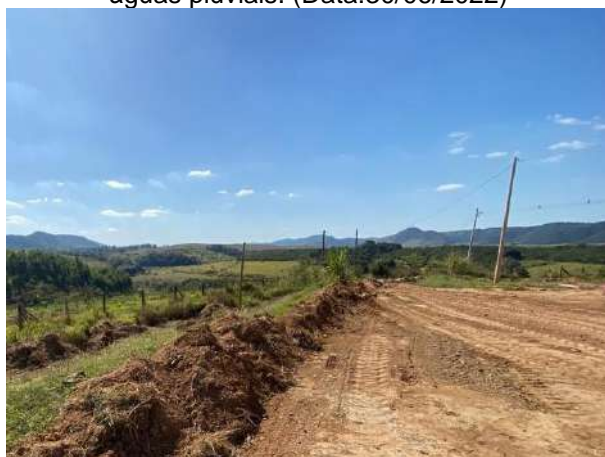
Foto 286 – Leira e gramíneas e disciplinamento de águas pluviais. (Data:30/07/2022)
