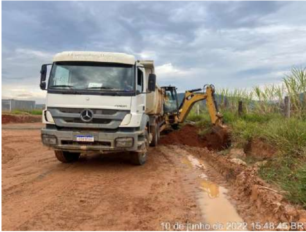
Foto 362 – Movimentação de terra, margem direita. (Data:10/06/2022)
