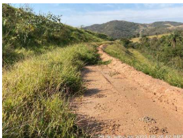
Foto 229 – Leira de proteção no entorno. Bota Fora 01. (Data: 29/07/2022)
