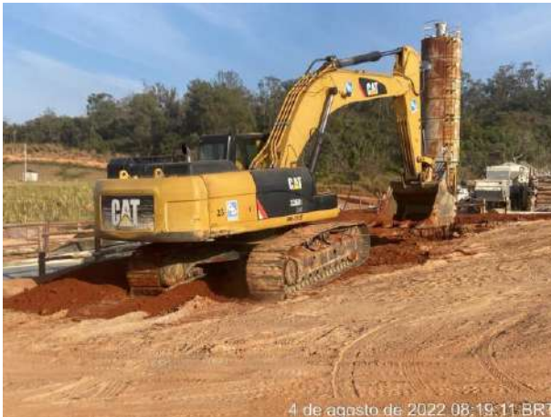
Foto 374 – Movimentação de terra, margem direita. (Data:04/08/2022)
