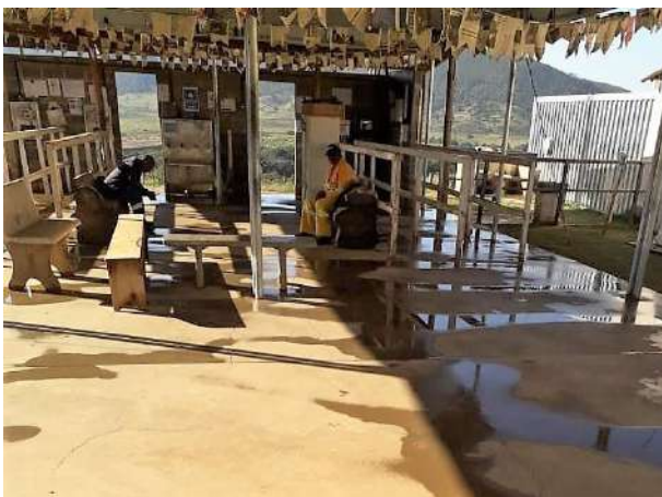
Foto 89 – Limpeza da área de vivência, canteiro industrial. (Data:27/06/2022)
