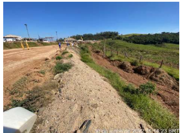
Foto 285 – Talude, leira e gramíneas. (Data:30/06/2022)
