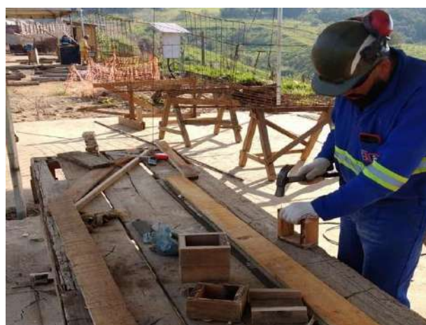
Foto 120 – Construção das caixas no modelo estilo INPA. (Data: 04/06/2022)
