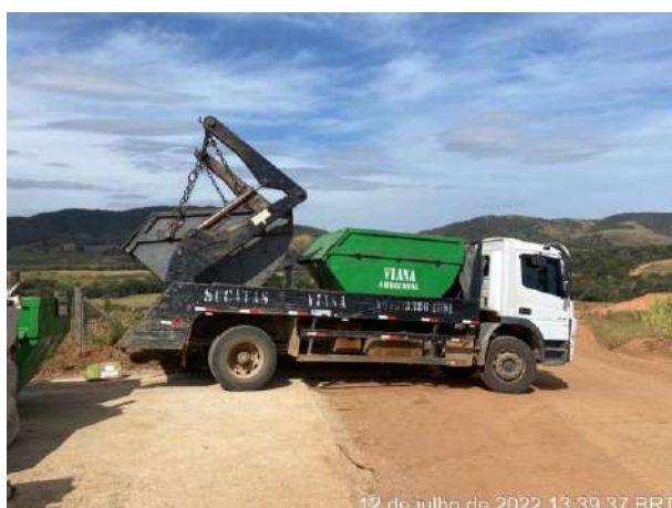
Foto 334 – Troca de caçambas de resíduos comum no canteiro Industrial. (Data:12/07/2022)
