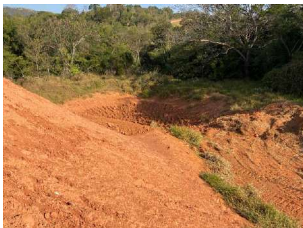
Foto 203 – Vista para cacimba limpa. (Data:14/07/2022)
