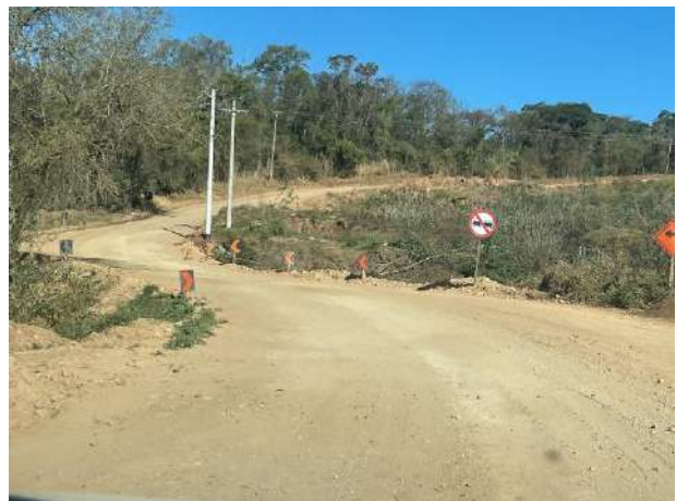
Foto 180 – sinalização na via municipal de acesso a obra. (Data:25/08/2022)
