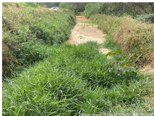
Foto 238 – Vista para Canaleta. Bota Fora 01. (Data: 26/08/2022)
