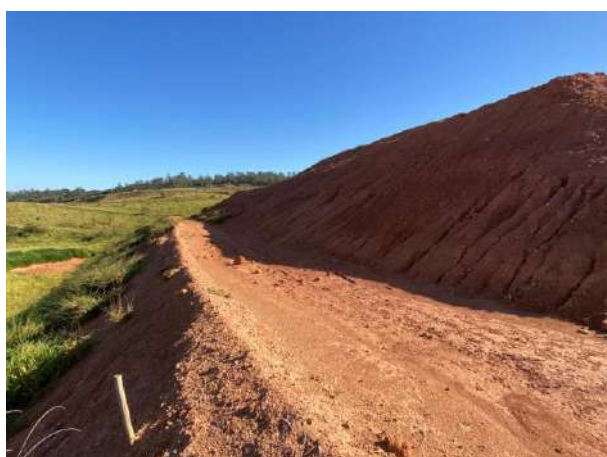
Foto 196 – – Vista para leira e inclinação e direcionamento para saia do talude (Data:23/06/2022)
