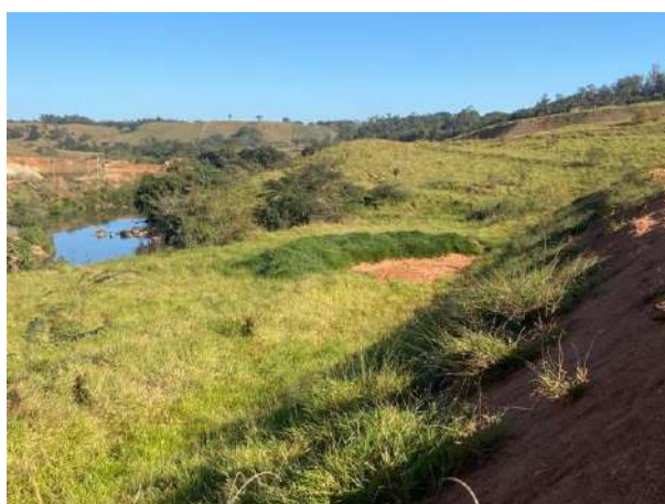
Foto 197 – Vista para cacimba limpa. (Data:23/06/2022)
