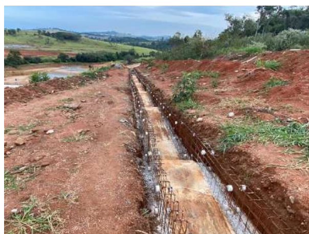
Foto 276 – Canaletas de drenagem. (Data:23/06/2022)
