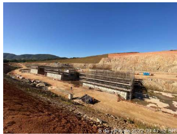
Foto 371 – Aplicação de Concreto. (Data:08/07/2022)
