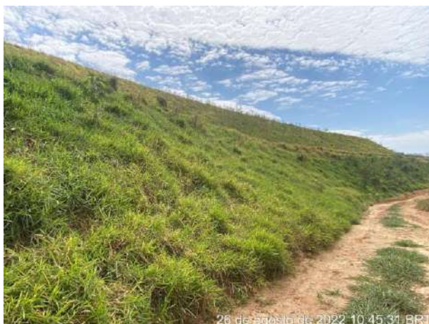
Foto 233 – Vista da cobertura vegetal. Bota Fora 01. (Data: 26/08/2022)
