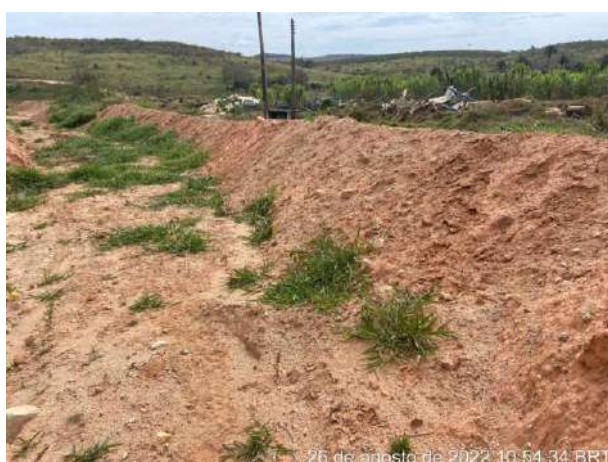
Foto 235 – Leira de proteção no entorno. Bota Fora 01. (Data: 26/08/2022)
