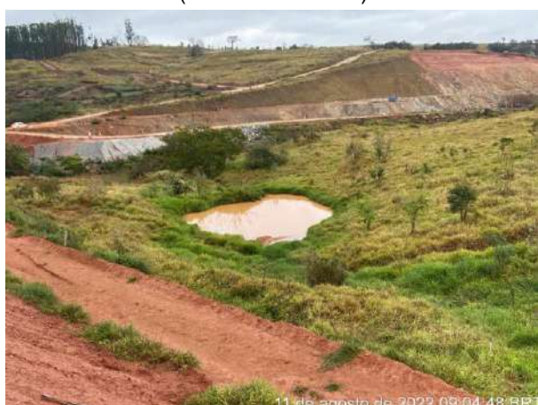
Foto 208 – Vista para cacimba de retenção de sedimento. (Data:11/08/2022)
